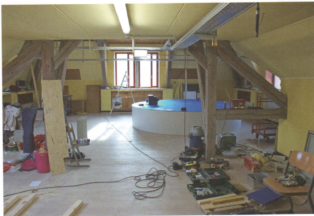
travaux îlot Computarium
